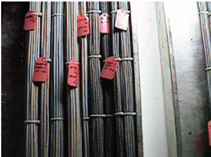
线槽内线缆安装图
