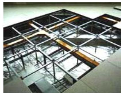
槽两类管槽互不混合、交叉，平行距离符合相关规范。这样可实现电力电缆与通信电缆两类电缆互不混合。
